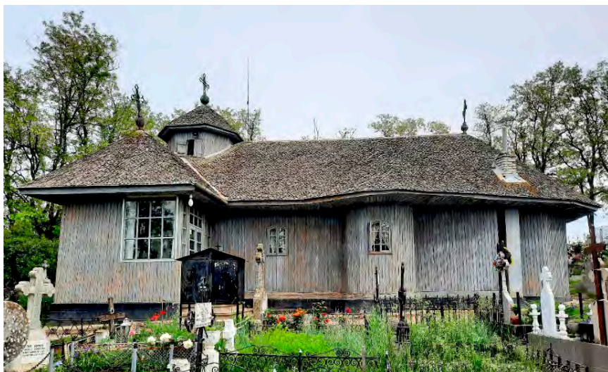
Fig. 1. Biserica „Adormirea Maicii Domnului” din Turturești (vedere dinspre sud – foto: C. Preoteasa, 2020)
